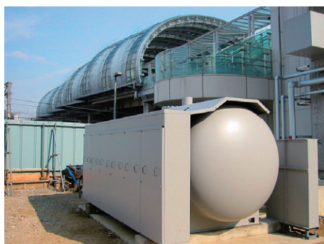
駅施設(スプリンクラー設備)
