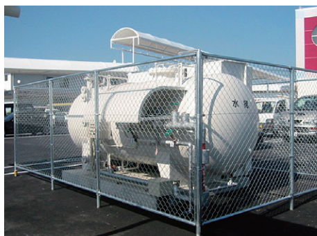
商業施設(屋内消火栓設備)
