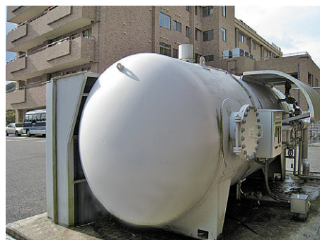
救護施設(スプリンクラー設備)
