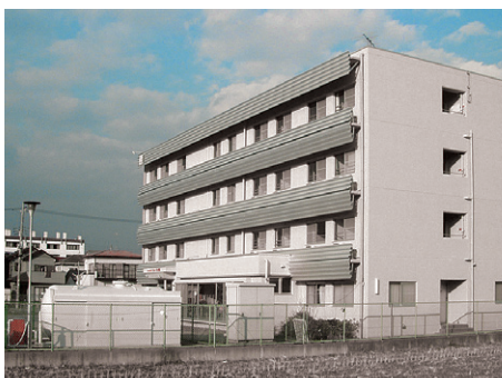
福祉施設(スプリンクラー設備)
