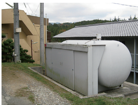
宿泊施設(スプリンクラー設備)
