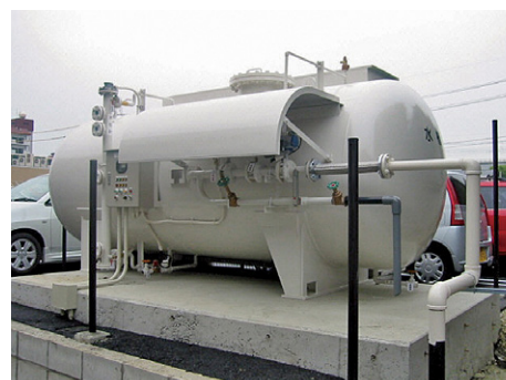
商業施設(屋内消火栓設備)
