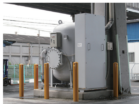
公共施設(泡消火設備-任意設置-)
