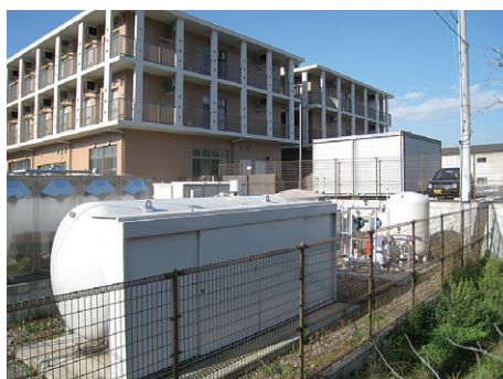
福祉施設(スプリンクラー設備)
