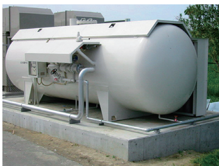
食肉センター(屋外消火栓設備)
